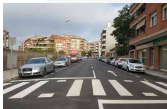
Repintat i millora de l'asfaltat de diversos carrers al barri del Poble Sec
