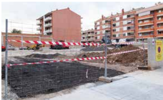
Tasques d'asfaltat zona blanca d'aparcament carrer Piera
